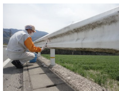
ガードレール磨き前
