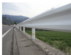
ガードレール磨き後
